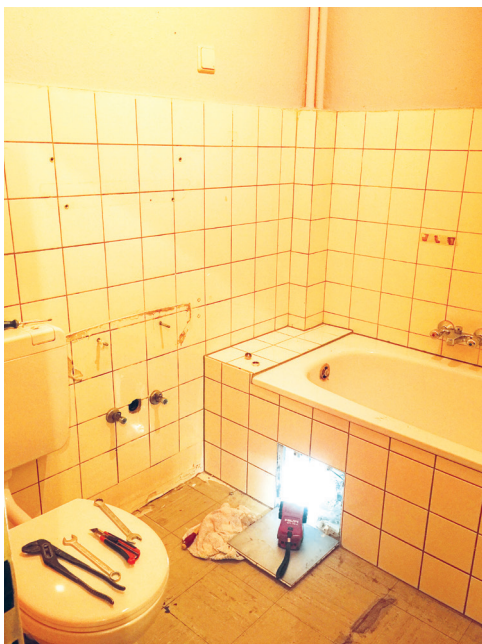
vor der Renovierung
